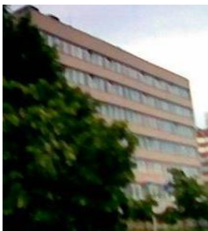
Az elkészült épület.
