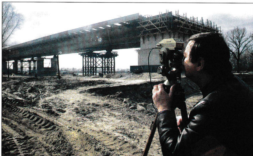
Hídpillér kitűzés az M0 Duna hídjánál
