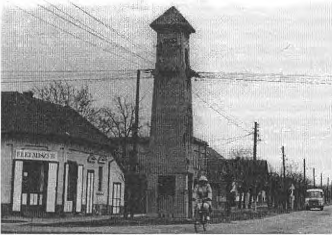
2. ábra. Régi 10/0,1 kV-os toronyállomás új szerepkörben
