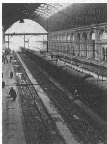
7. ábra. A középperon fénycsöves berendezése a 60-as évek elején
