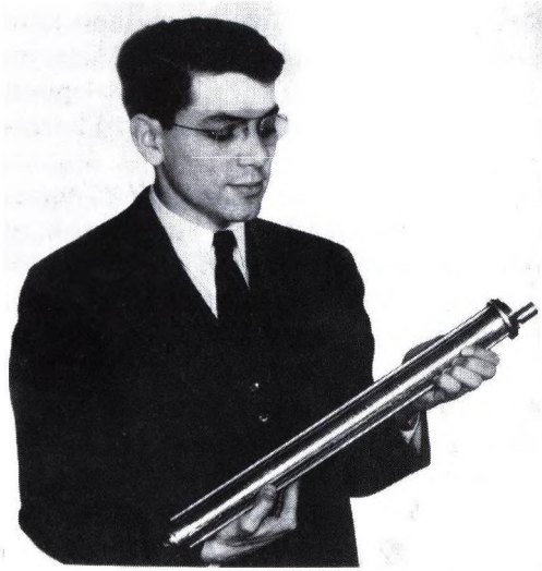
9. ábra. A soros számítógépek memóriája, a késleltető művonal. A képen Isaac Auerbach kezében látható a UNIVAC-ban használt (1946/47) higanyos művonal.
