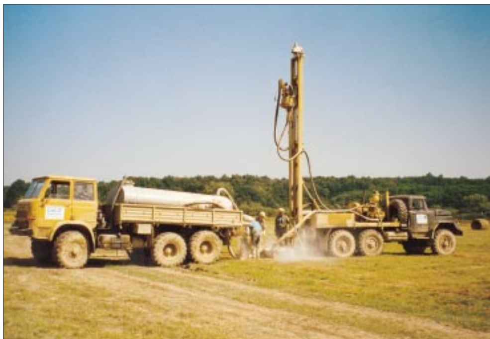
144 Tartálykocsi és URB-2A2 fűrőberendezés munkában (1995)
